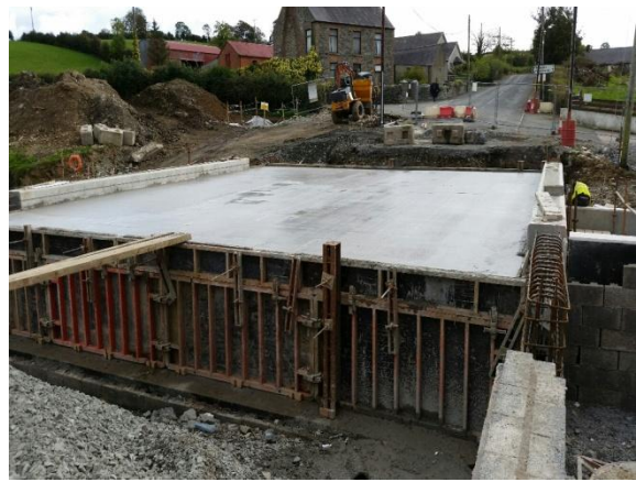
Concrete deck after pour
