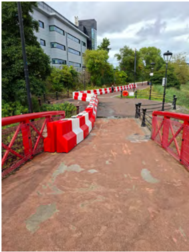
Bacainní Sealadacha Tuilte ag an Droichead Rua
