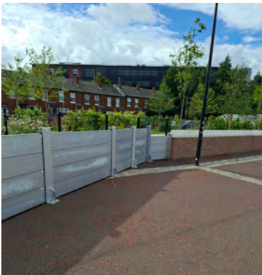
Bacainní Tuile Plainc agus Cuaille is Féidir a Bhaint as an Bhonn, ag an Léibheann Abhann
